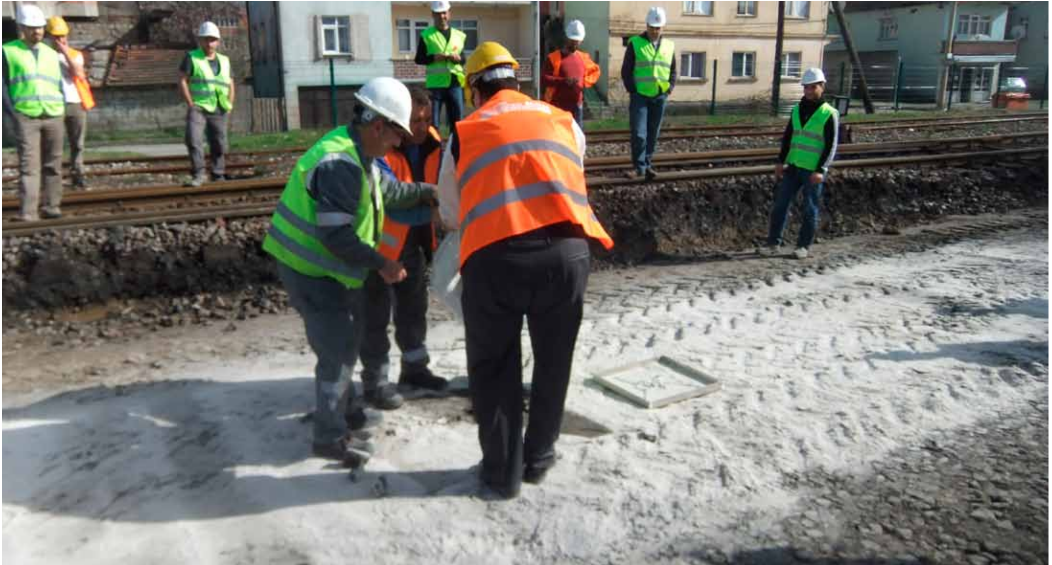
Kontrolle der ausgestreuten Menge NovoCrete
