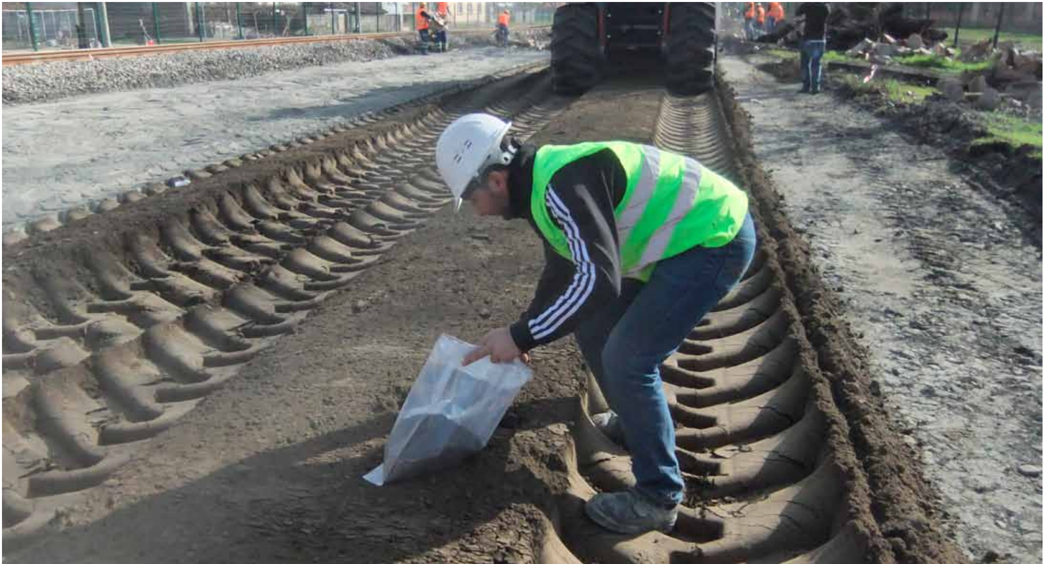
Kontrolle des Mischguts
