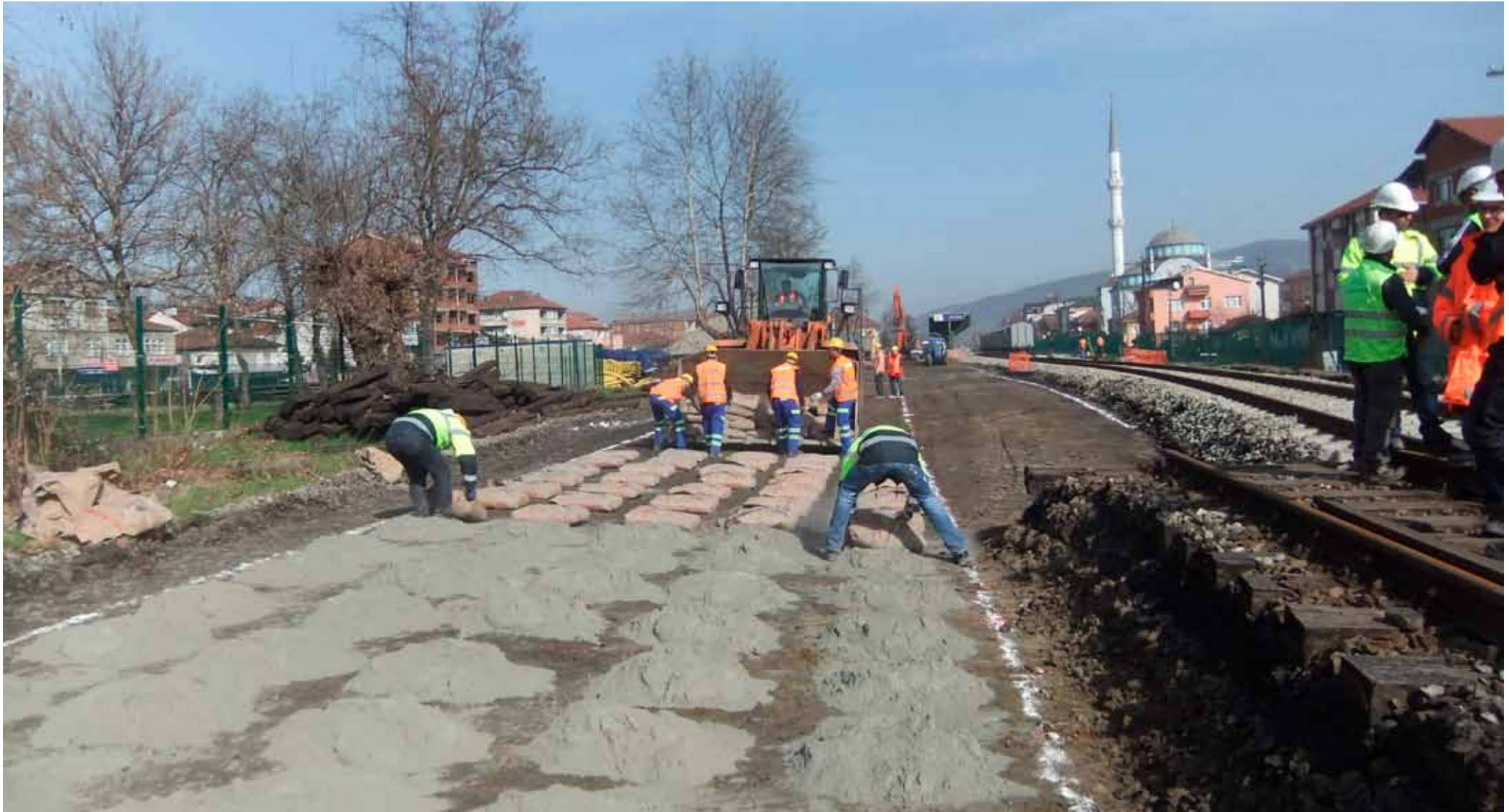
Manuelles Verteilen der Zementsäcke
