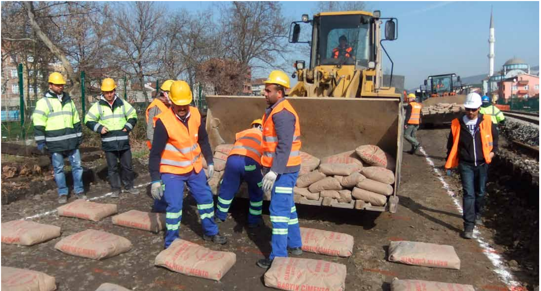
Manuelles Verteilen der Zementsäcke
