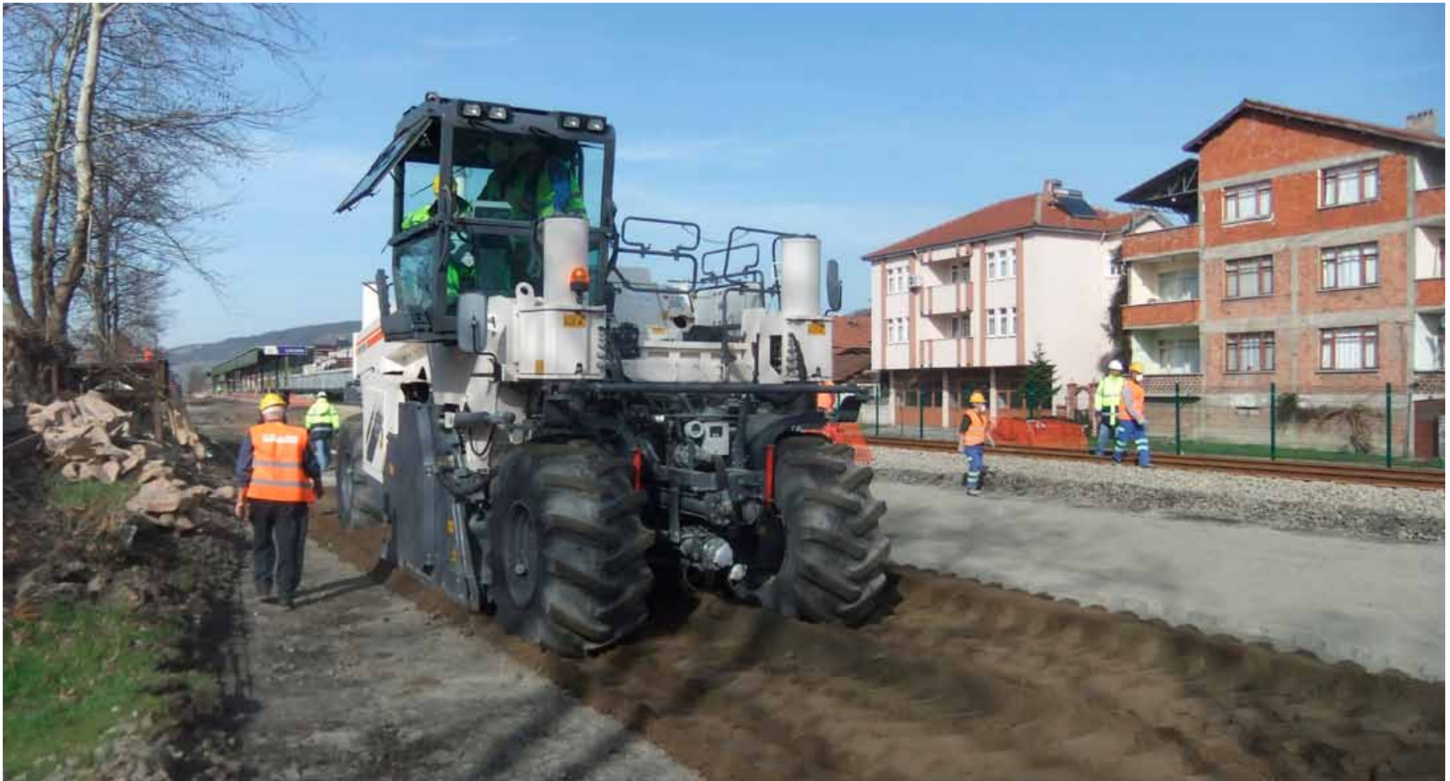
Einfräsen des Zement-NovoCrete-Gemischs
