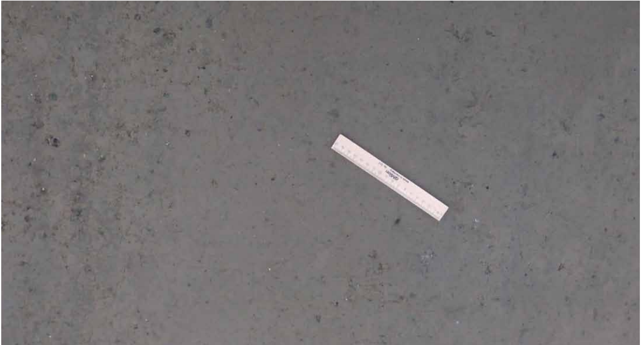
Detailansicht des fertiggestellten Feinplanums
