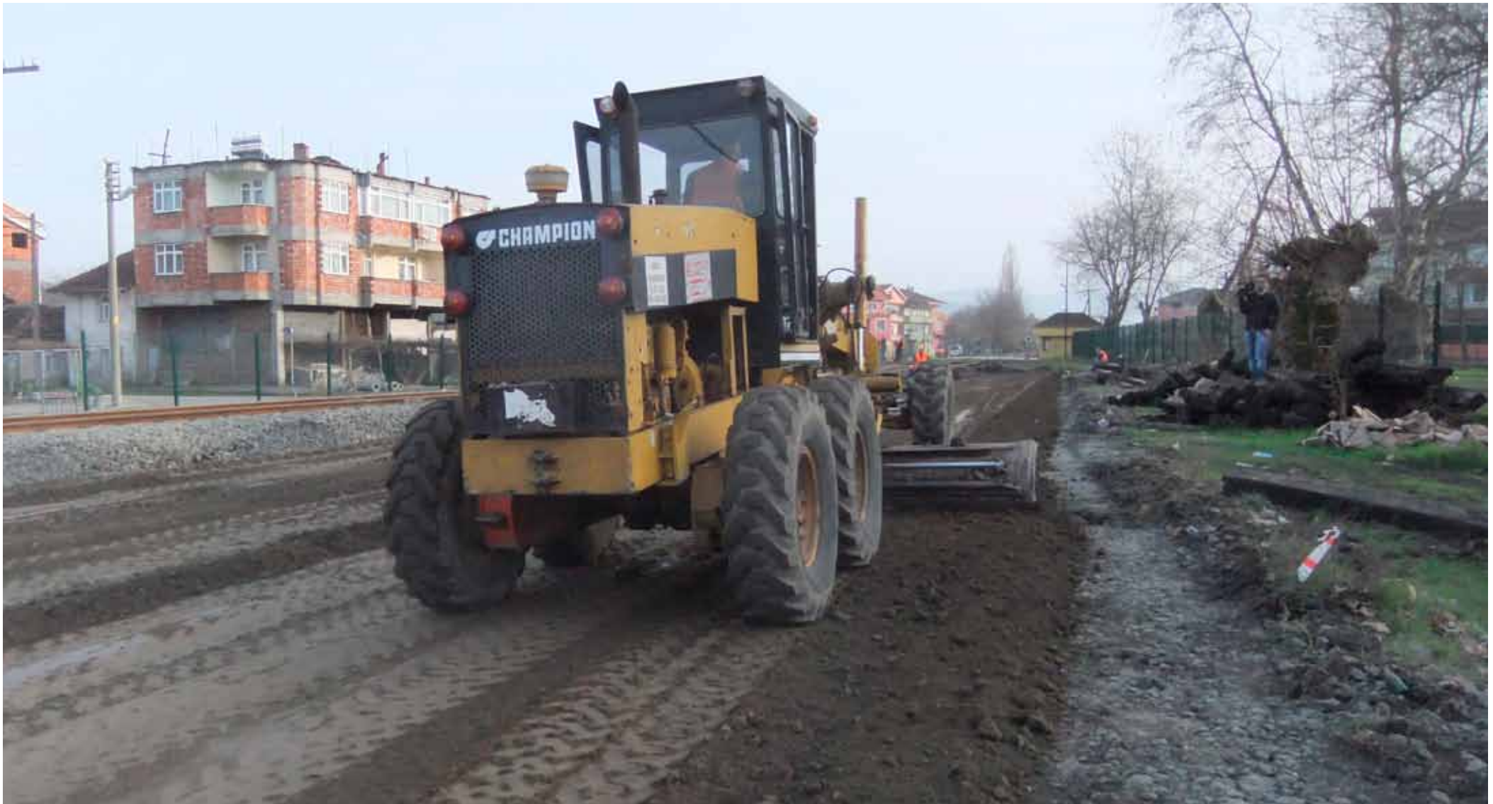
Levelling mit dem Grader
