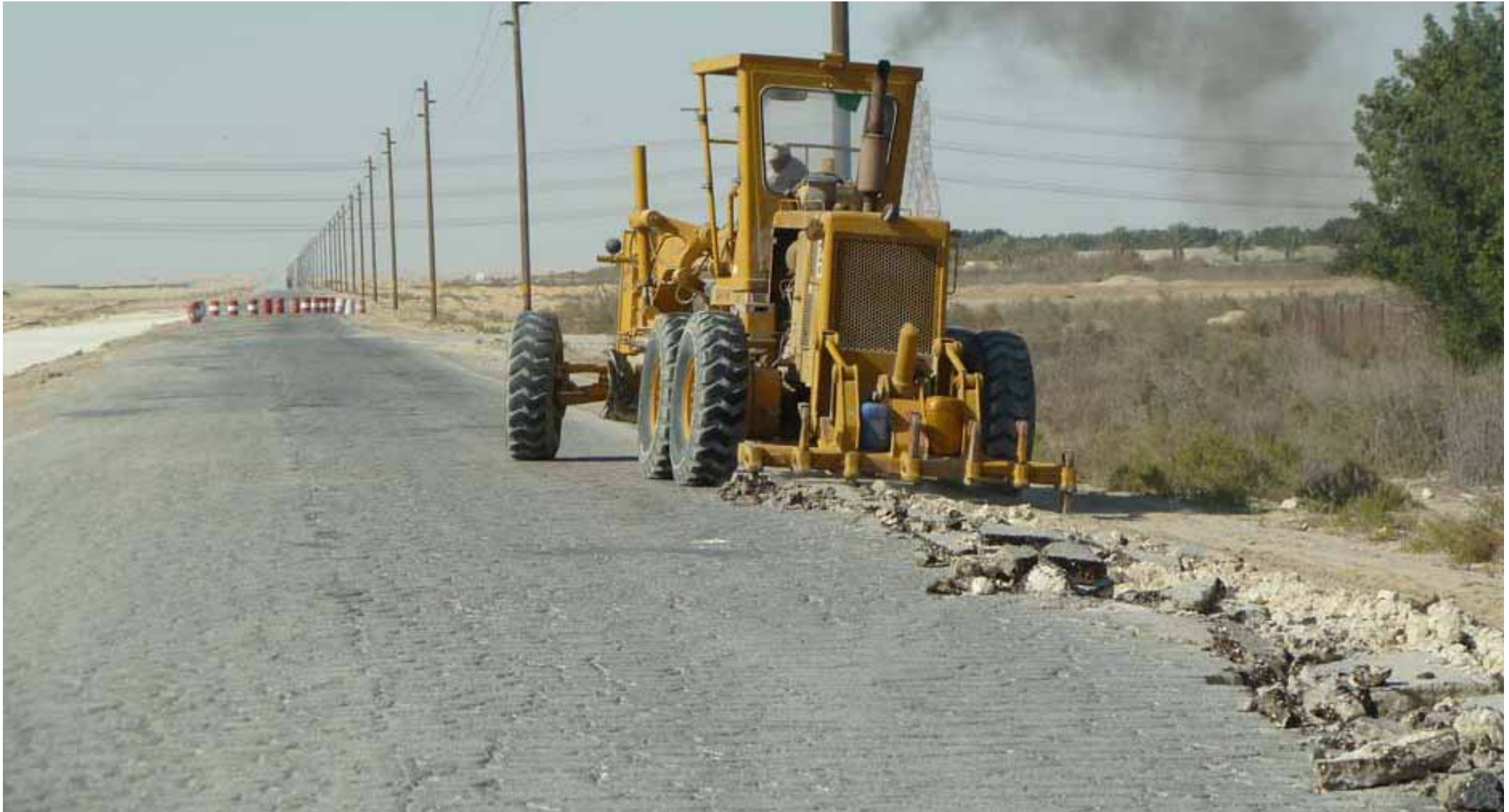
Aufbrechen des alten Asphaltbelags
