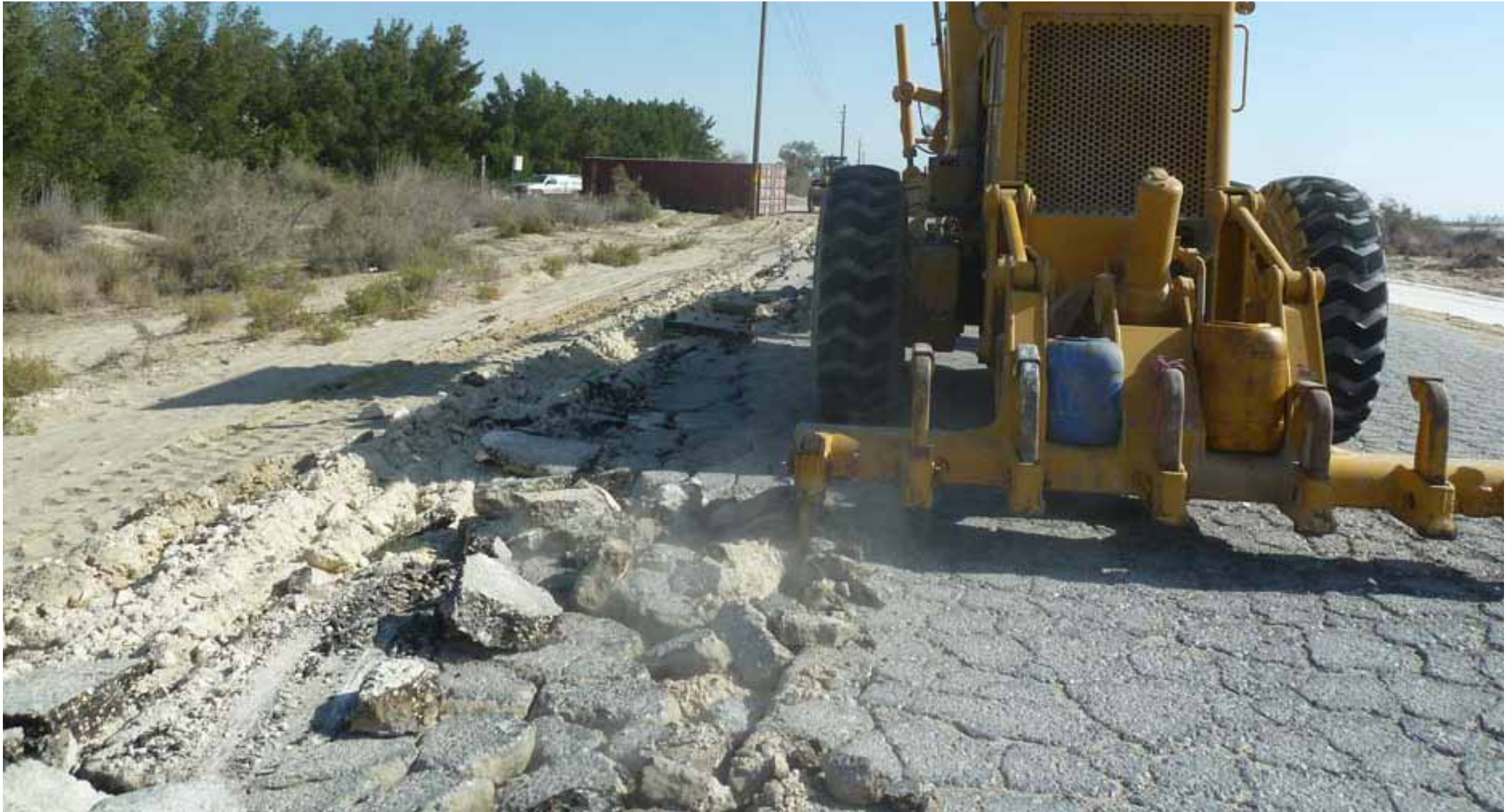
Aufbrechen des alten Asphaltbelags
