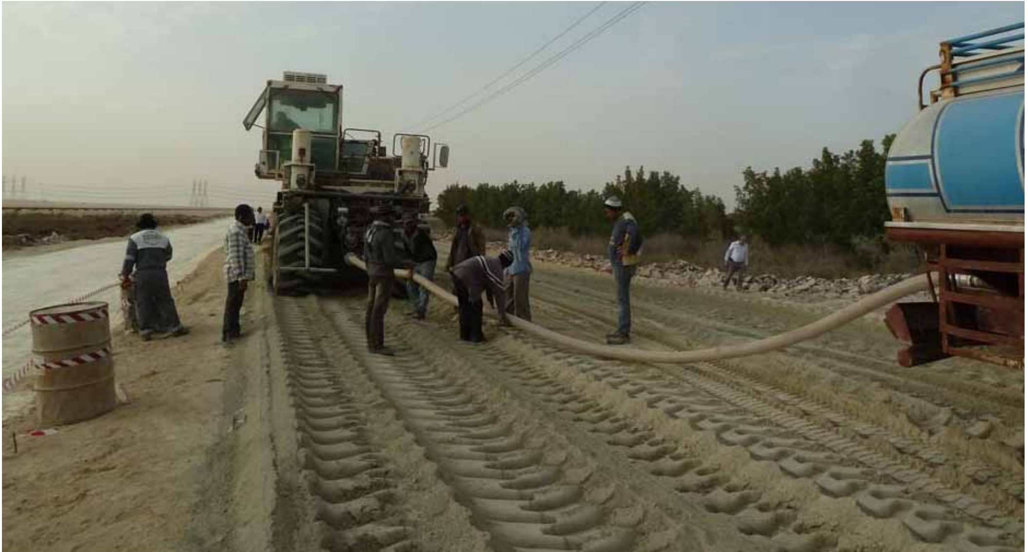
Fräsvorgang unter Zugabe von Wasser
