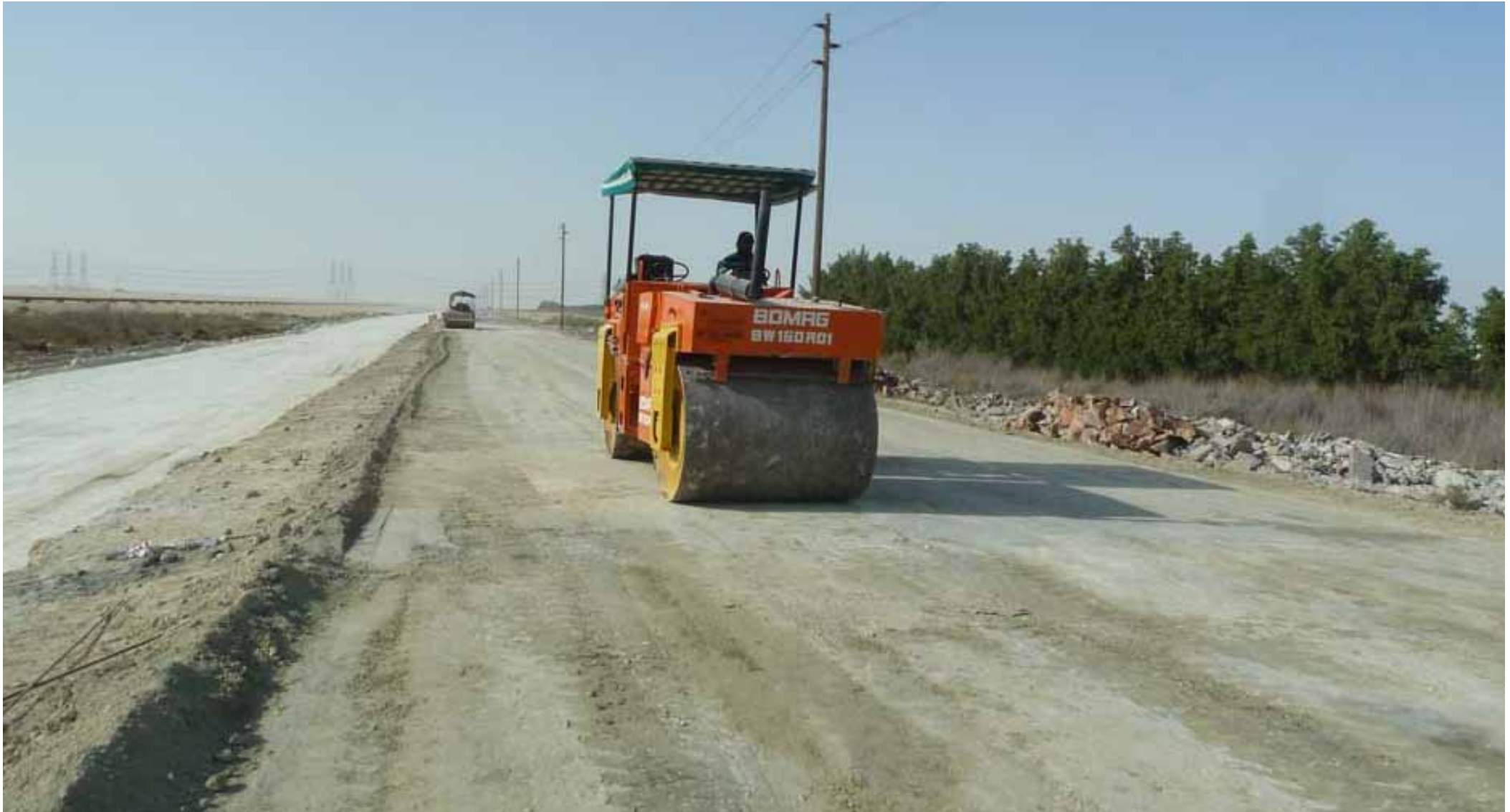
Verdichten des Feinplanums mit der Glattmantelwalze
