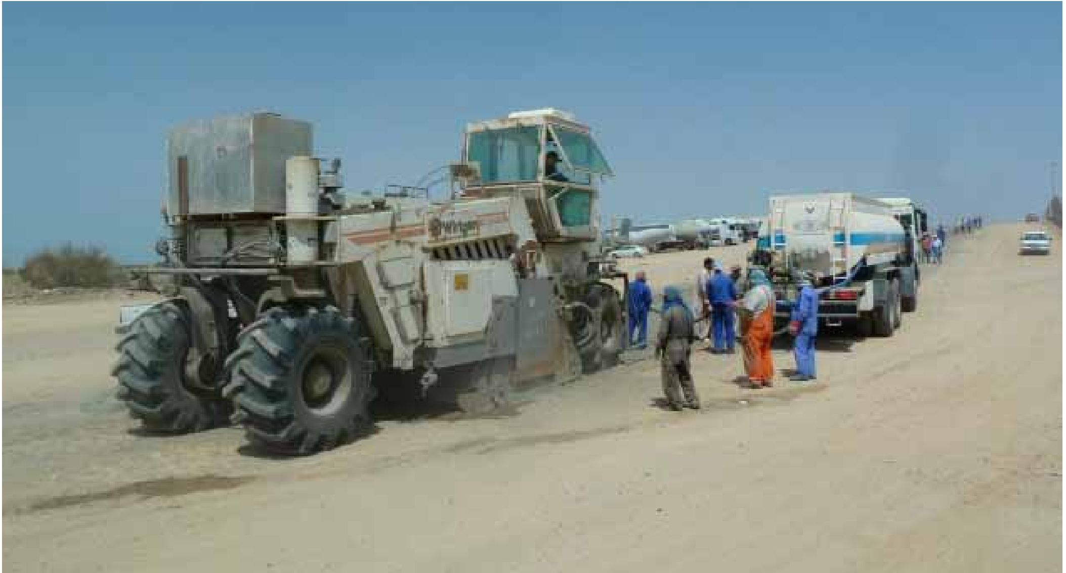
Einfräsen der Zement-Novocrete-Mischung bis zu einer Tiefe von 25 cm
