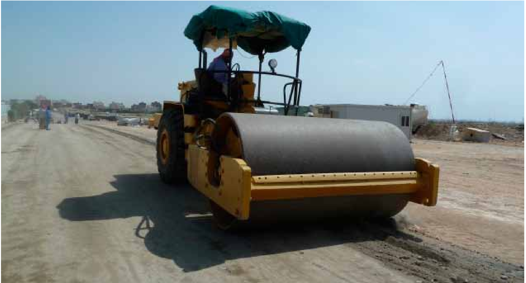
Dynamische und statische Verdichtung mit einem Glattmantelwalzenzug
