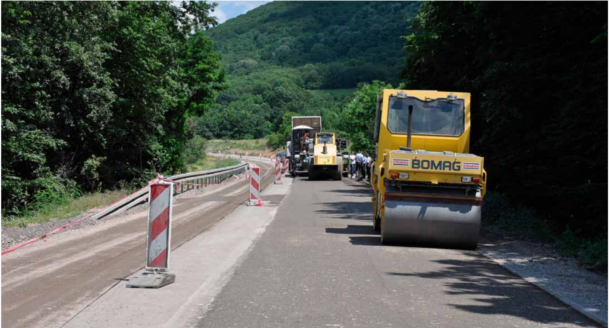
Verdichten der Fläche
