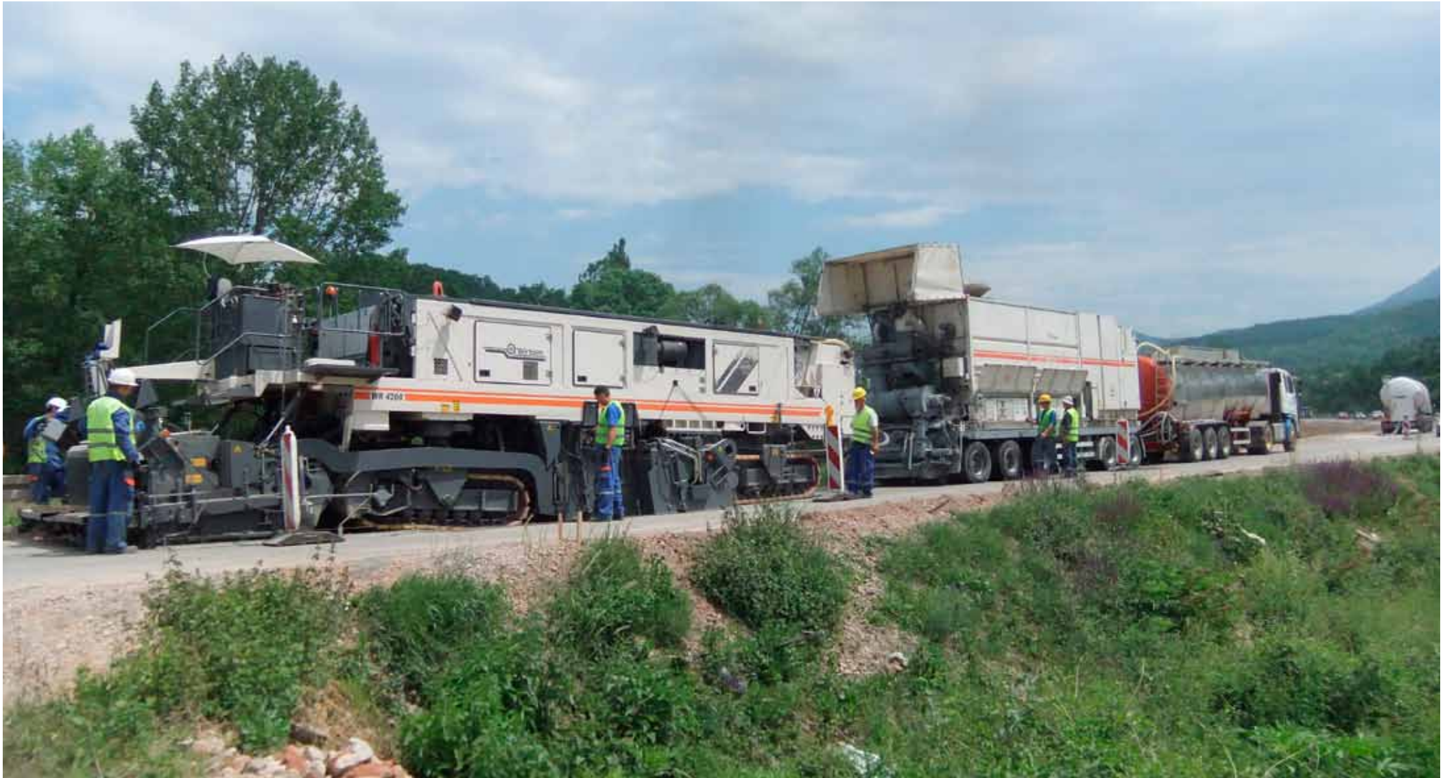
Einsatz des Mix Pavers
