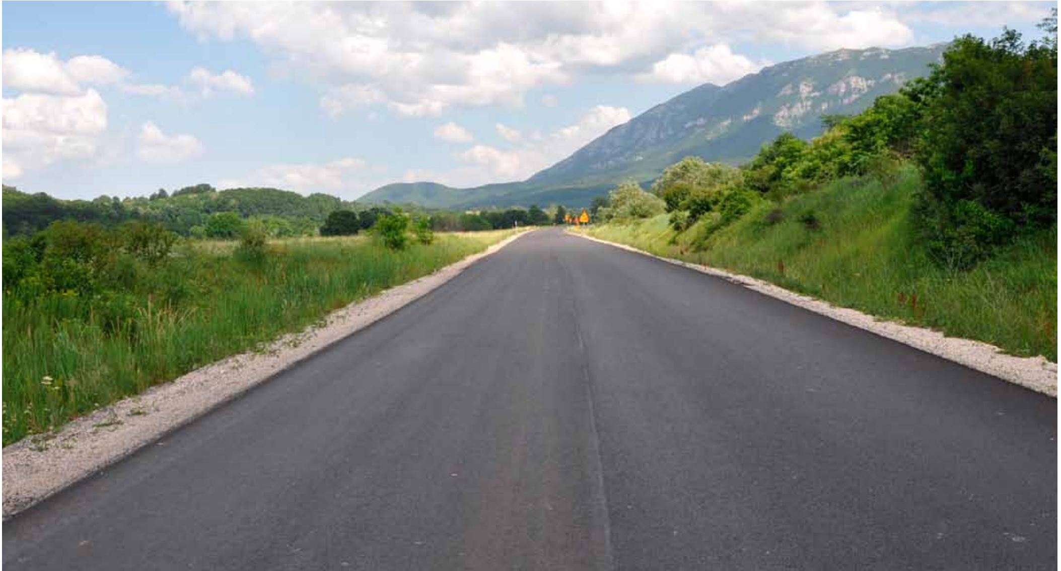
Fläche mit neuem Asphaltbelag
