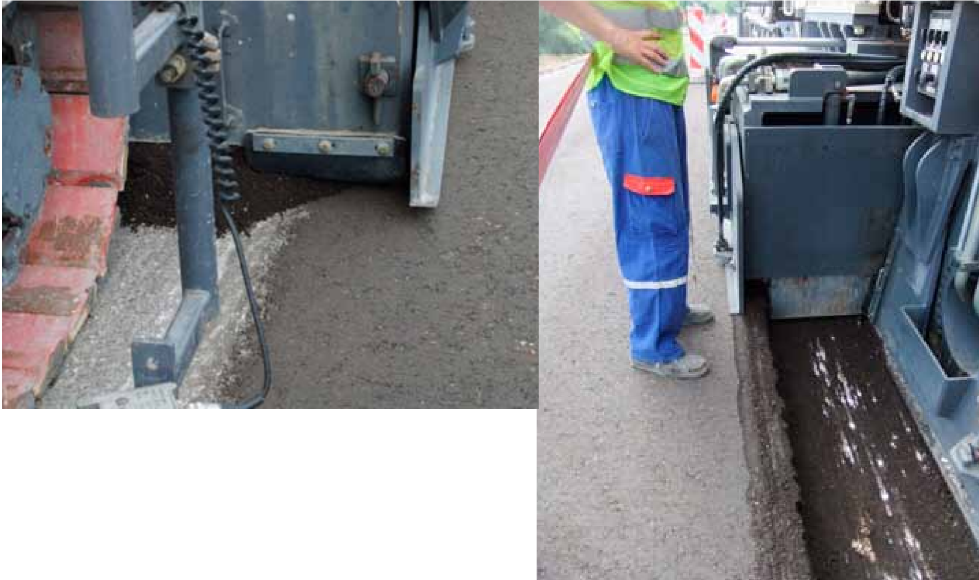
Einsatz des Mix Pavers
