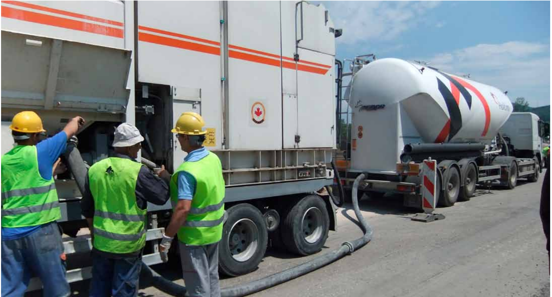
Befüllen der Slurry-Maschine mit Zement
