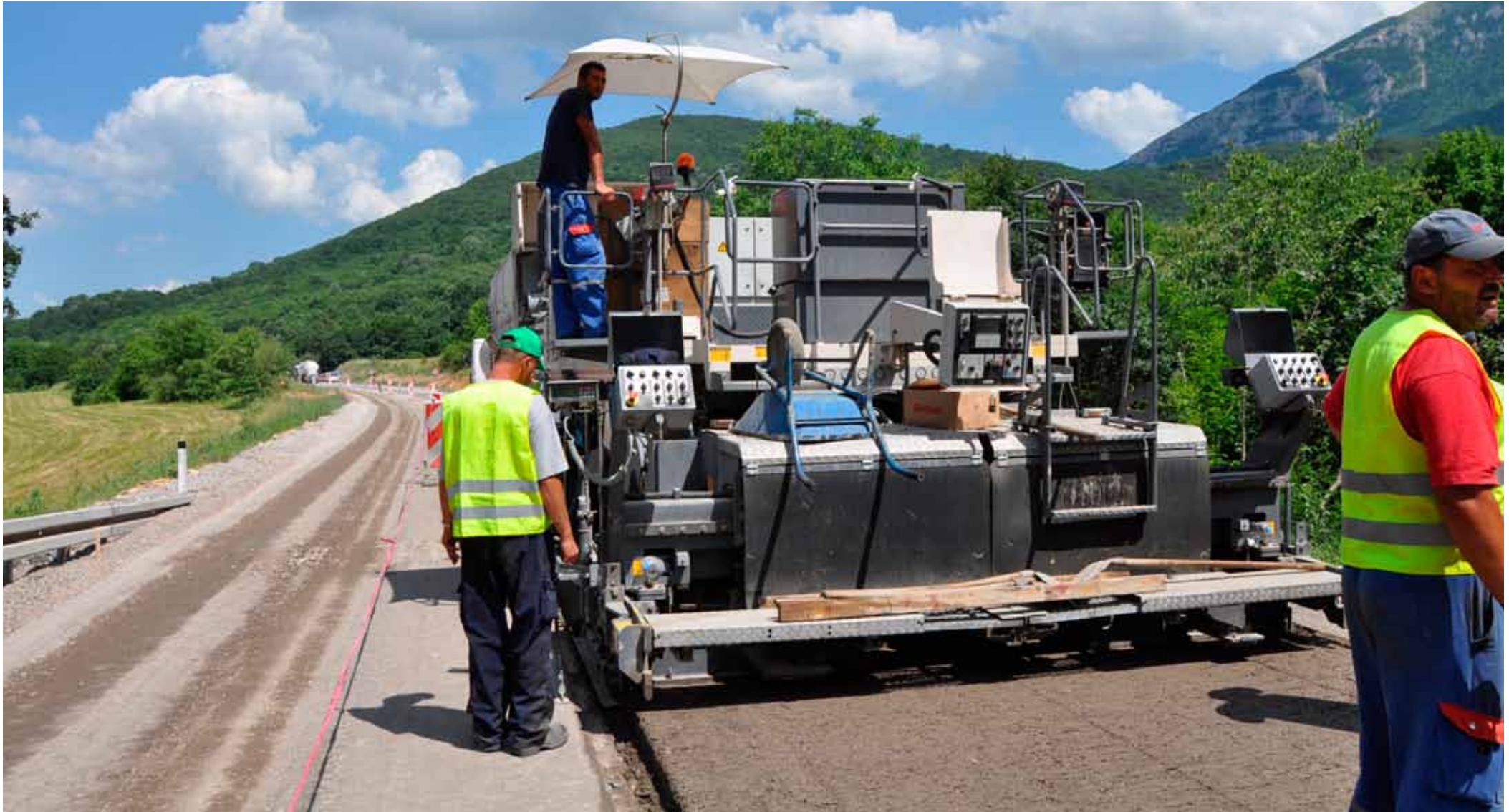
Einsatz des Mix Pavers
