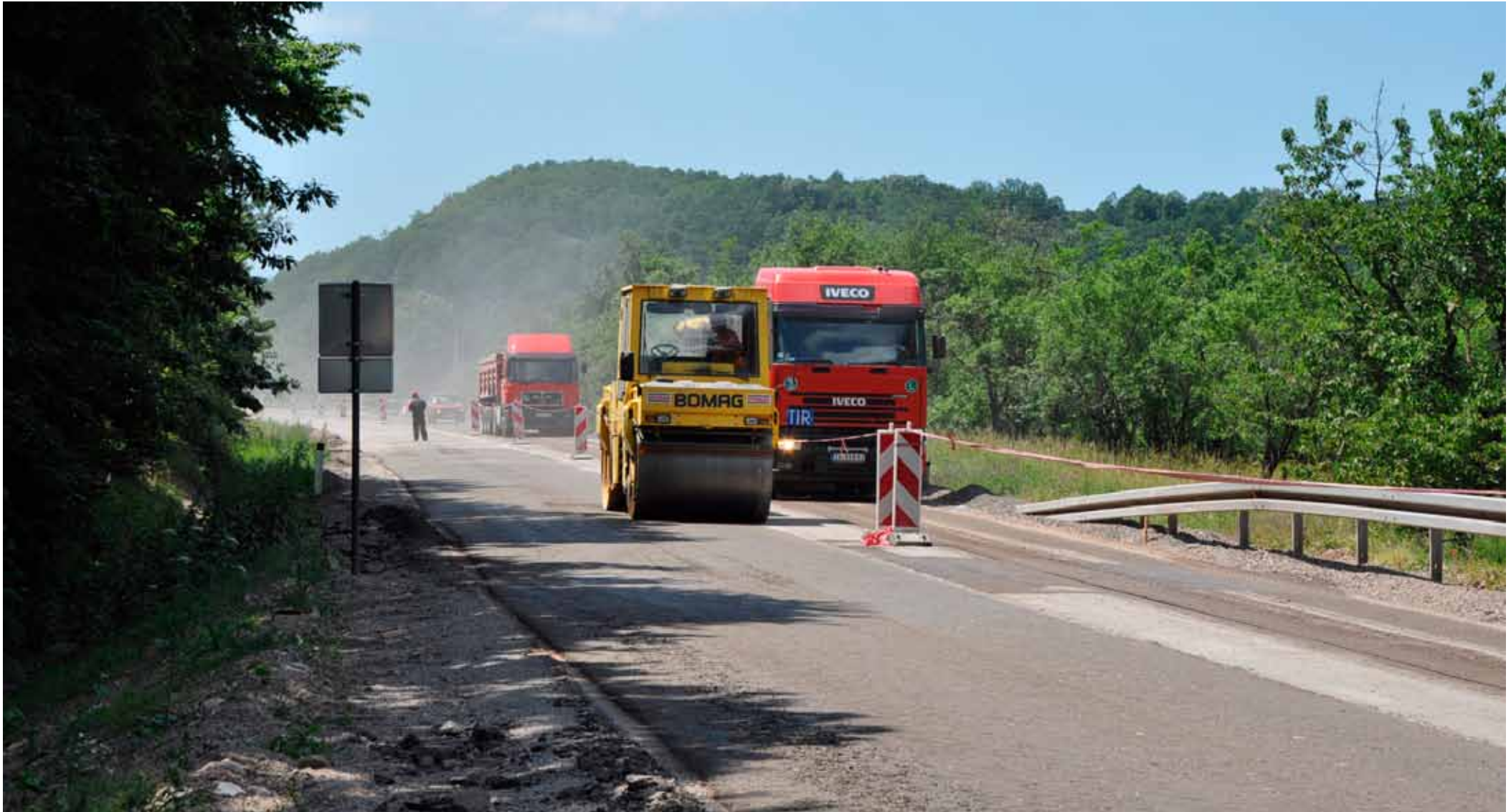
Verdichten der Fläche
