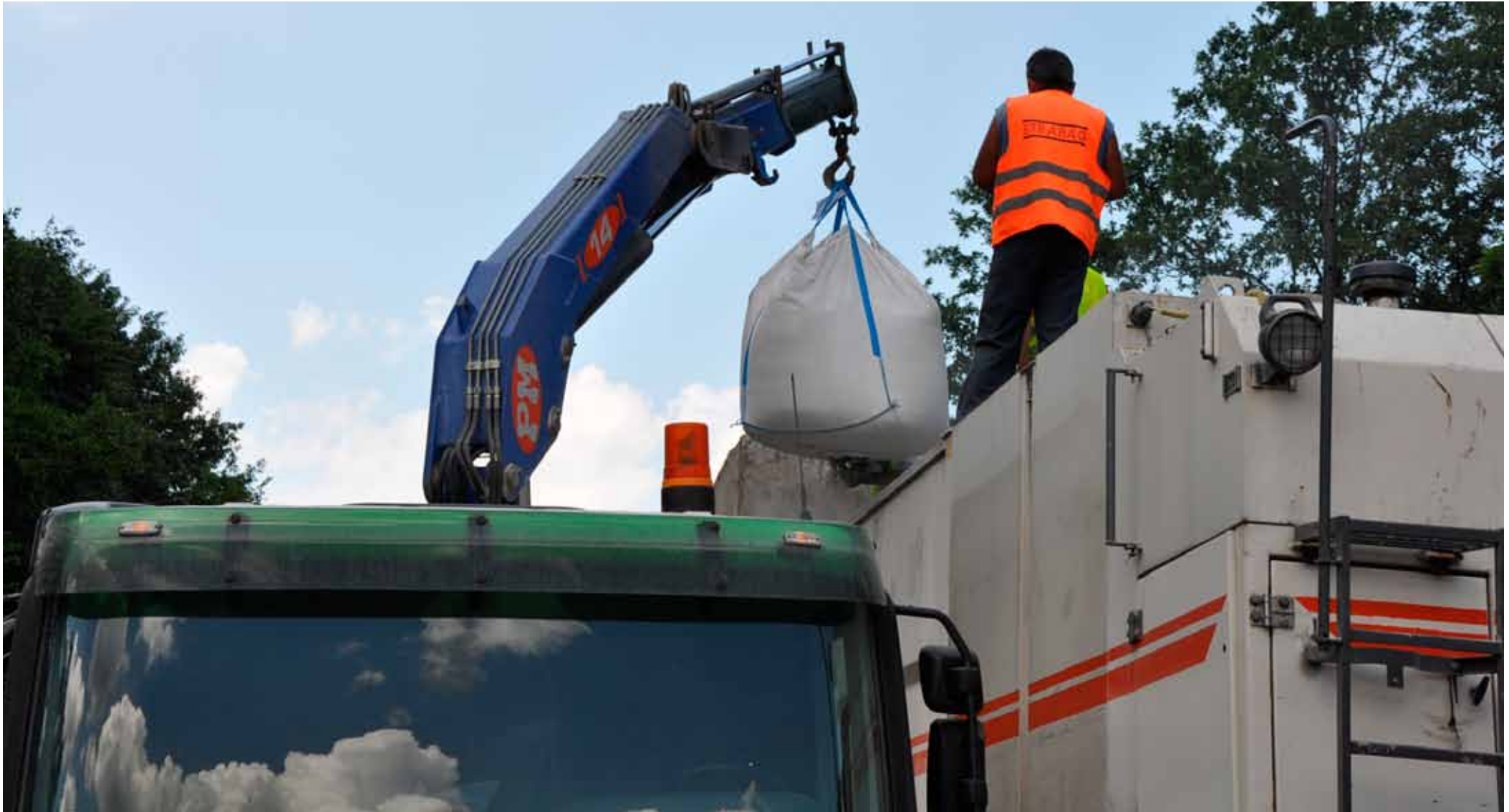
Befüllen der Slurry-Maschine mit NovoCrete
