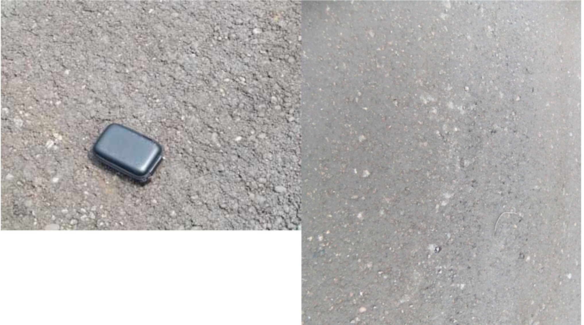
Detailaufnahme der Oberfläche nach dem Einsatz des Mix Pavers
