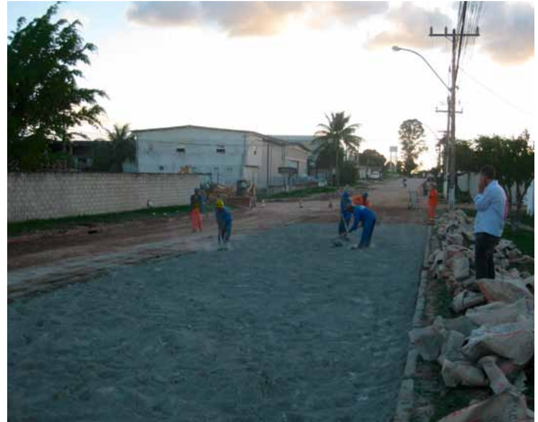
Manuelles Verteilen des Zements
