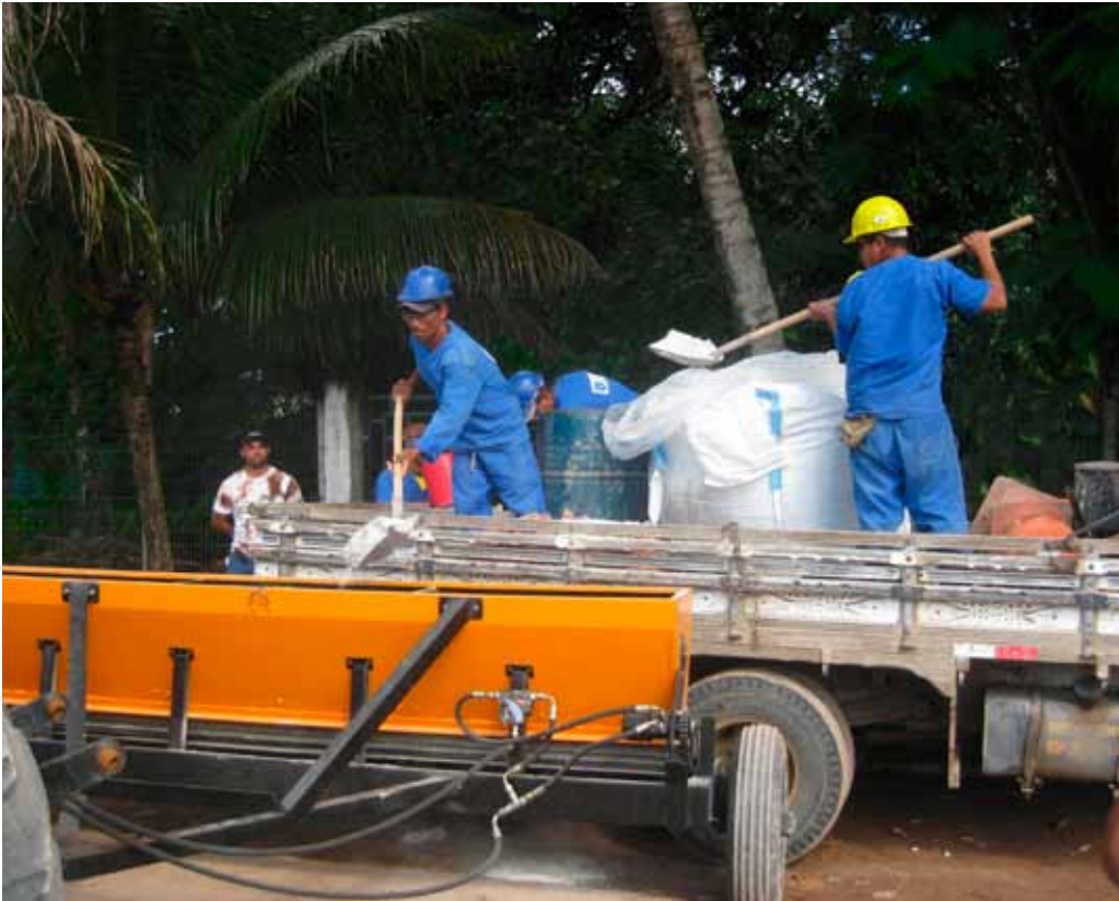
Befüllen des Anbaustreuers mit dem Zement-Additiv NovoCrete®
