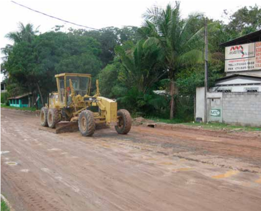
Einsatz des Graders für die Erstellung des Feinplanums
