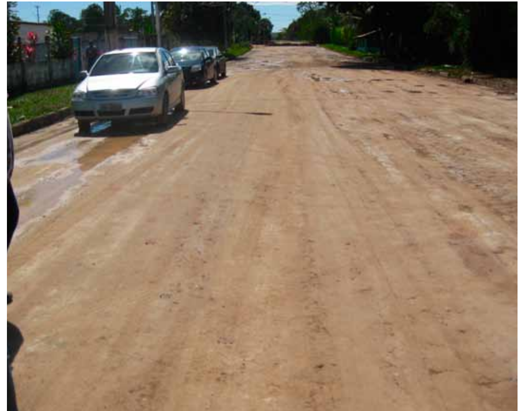
Fläche nach dem Verdichten
