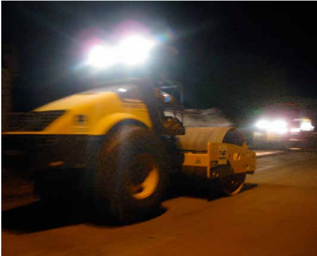
Statische und dynamische Verdichtung
