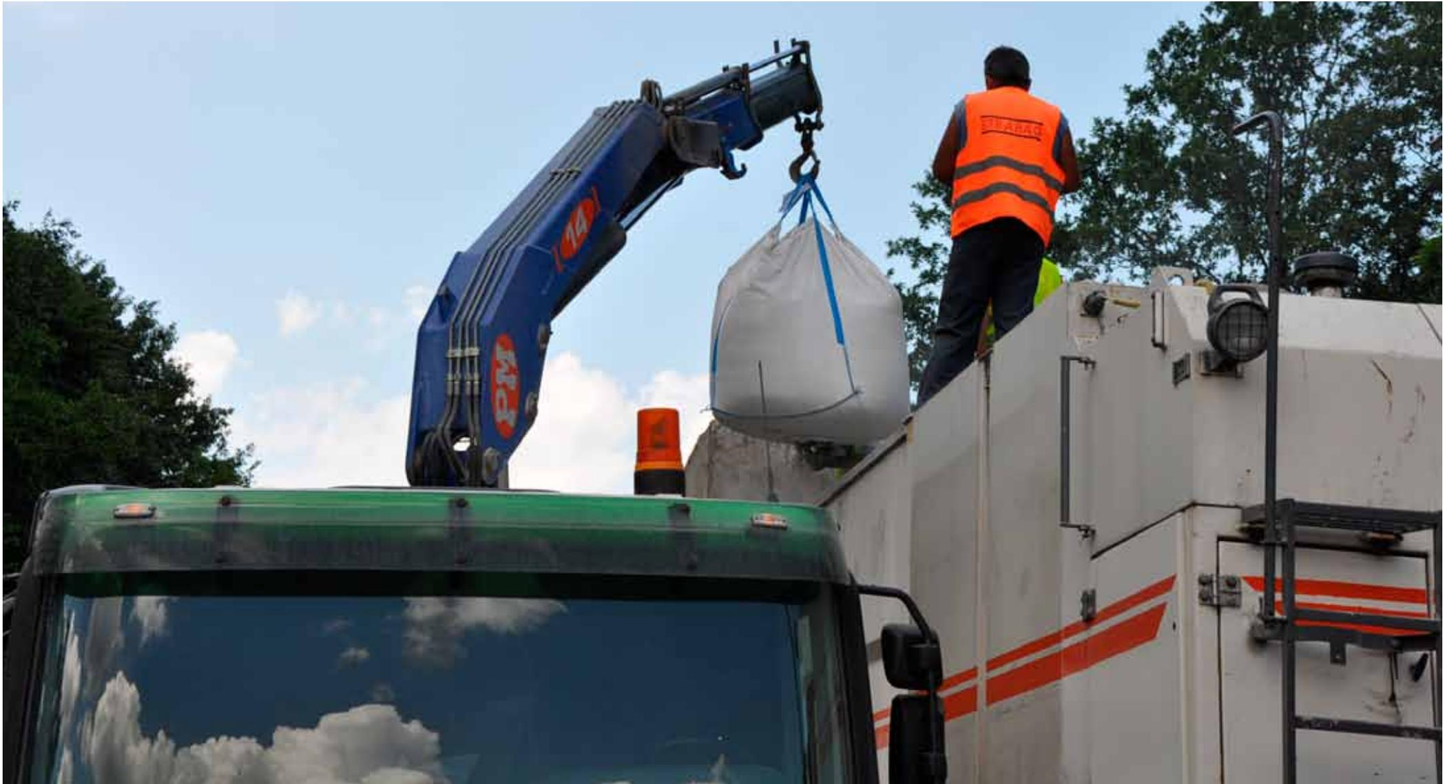
Befüllen der Slurry-Maschine mit NovoCrete
