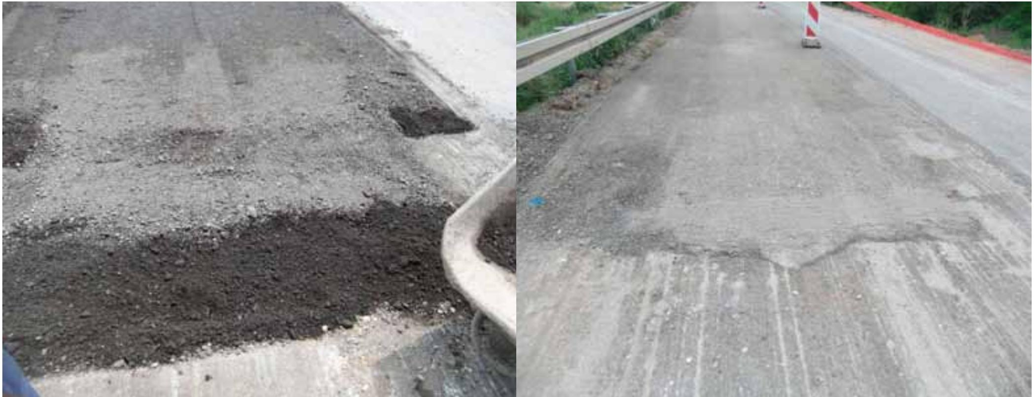
Ausgangssituation nach dem Abfräsen des alten Asphaltbelages
