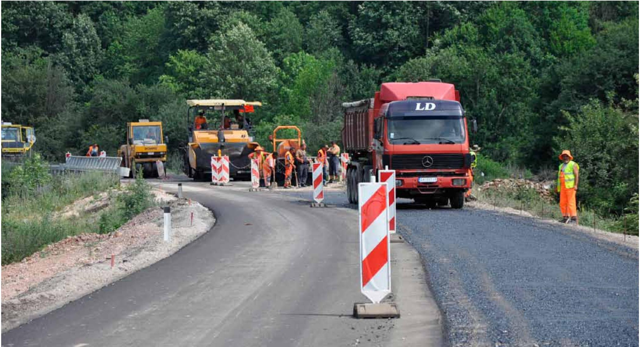
Einbau des neuen Asphaltbelages
