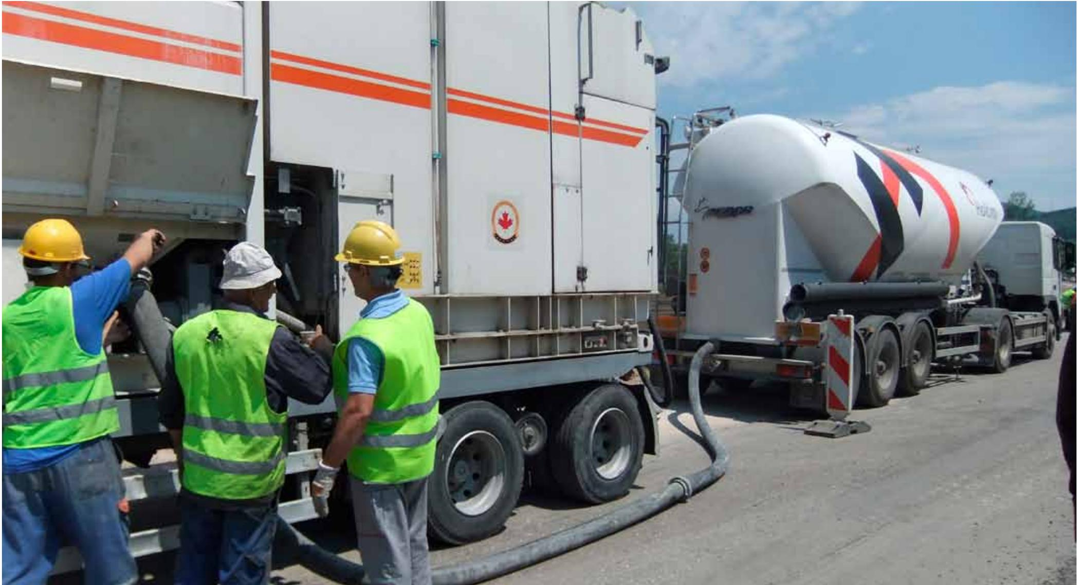
Befüllen der Slurry-Maschine mit Zement
