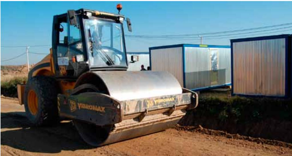
Dynamische und statische Verdichtung mit Glattmantelwalze (12 t Gewicht)
