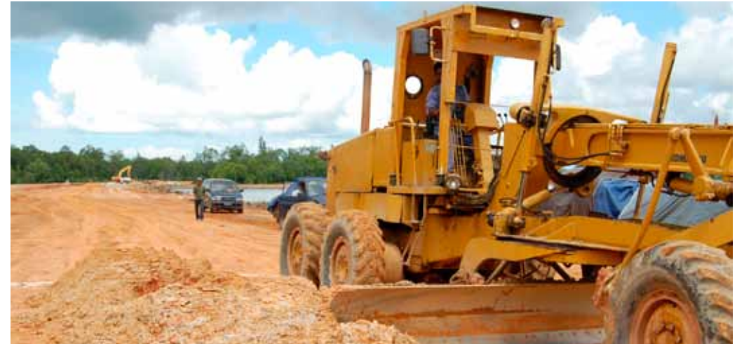
Auftragen und Verteilen des Erdreiches für die 2. Lage der zu stabilisierenden Schicht
