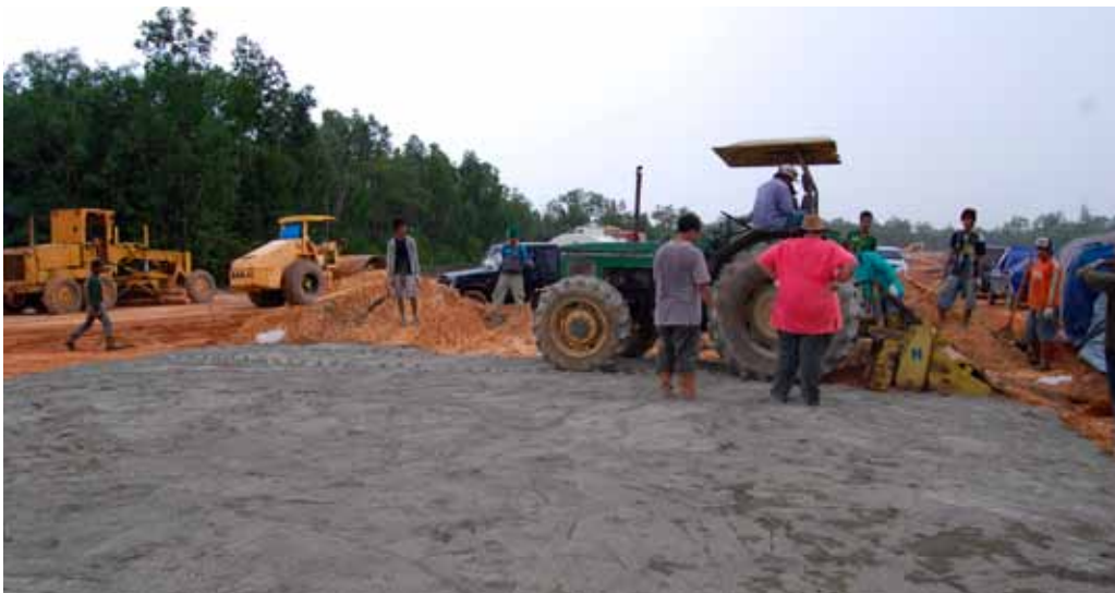
Ausstreuen der festgelegten Zementmenge (gesamt 200 kg/m 3 ) für die erste Lage
