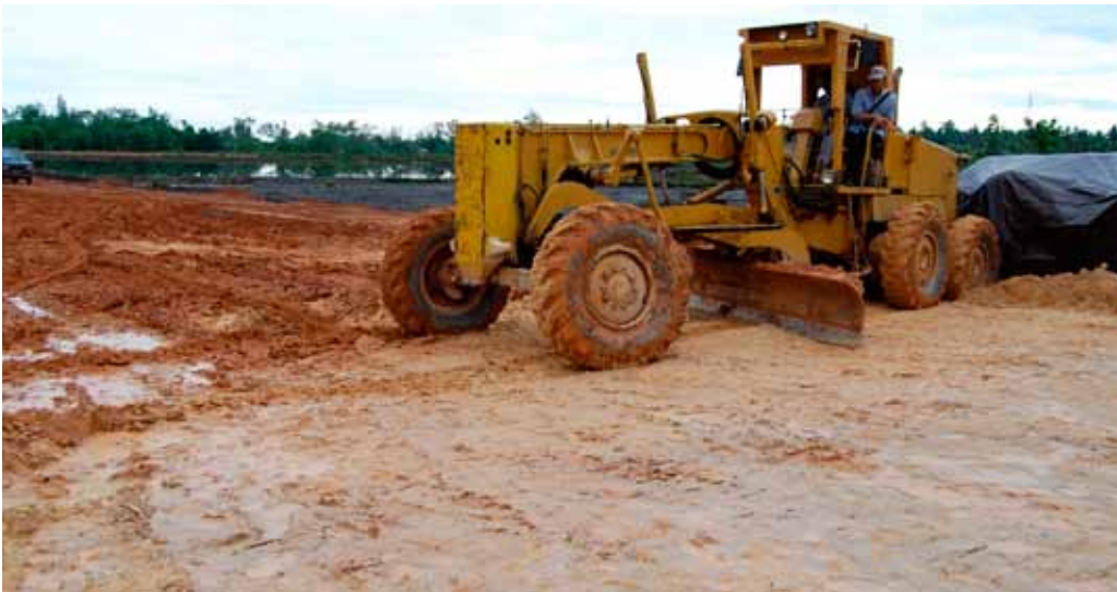
Levelling mittels Grader 20 Stunden nach der Verdichtung
