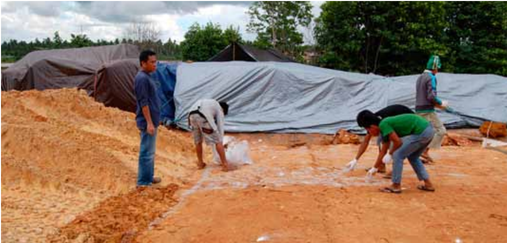
Manuelles Ausstreuen des Additives NovoCrete
