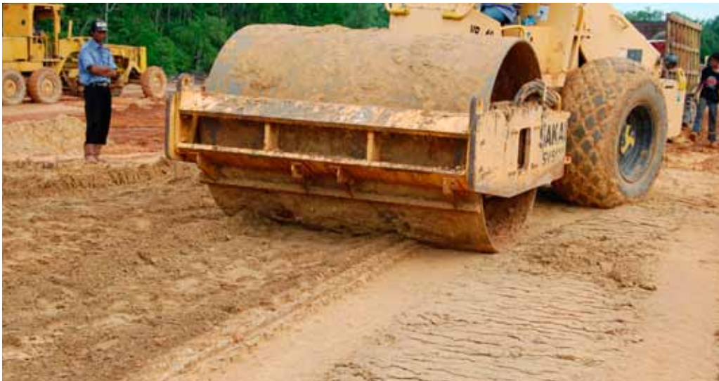
Verdichtung der ersten Lage um es gegen Eindringen von Wasser zu schützen
