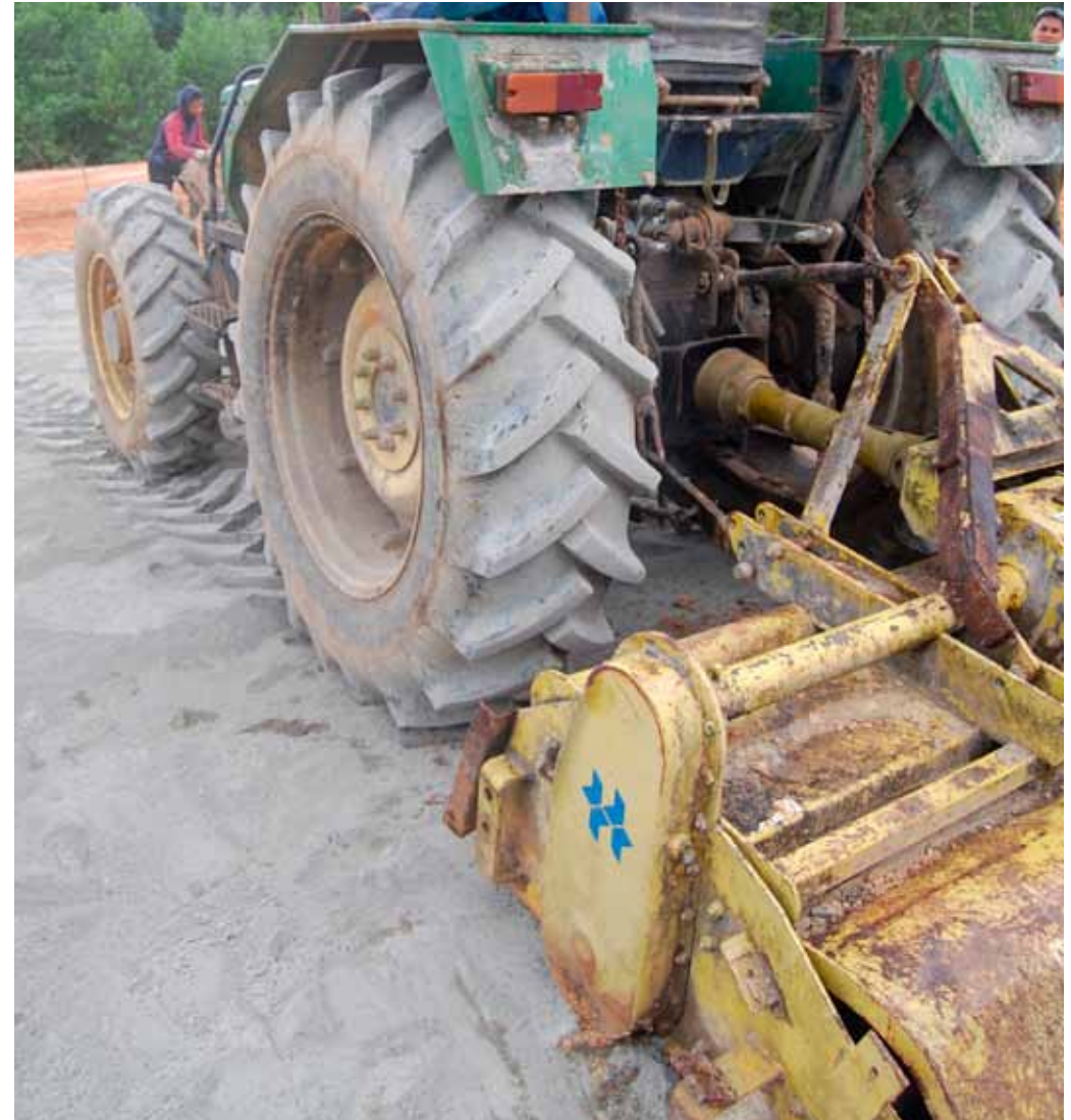
Beginn des Einfräsens der Bindemittelmenge
