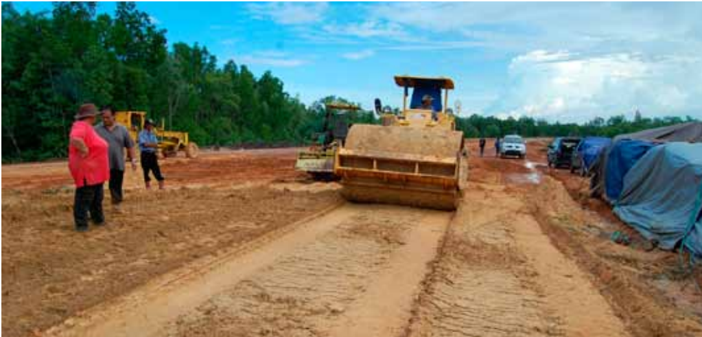
Statische und dynamische Verdichtung mit Walzenzug
