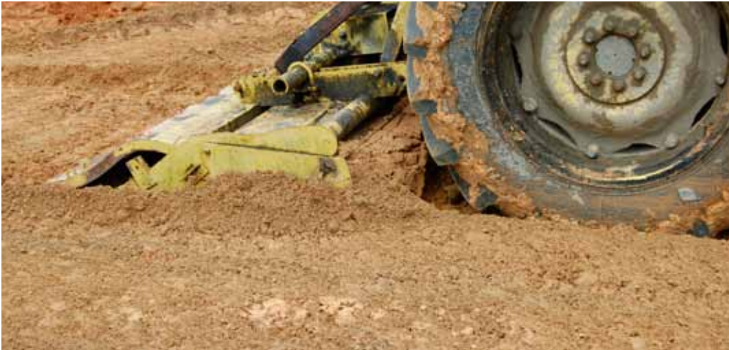
Einfräsen des NovoCrete-Zement-Gemischs für die 1. Lage unter starkem Regenfall
