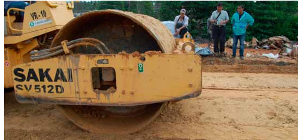
Statische und dynamische Verdichtung mit Walzenzug
