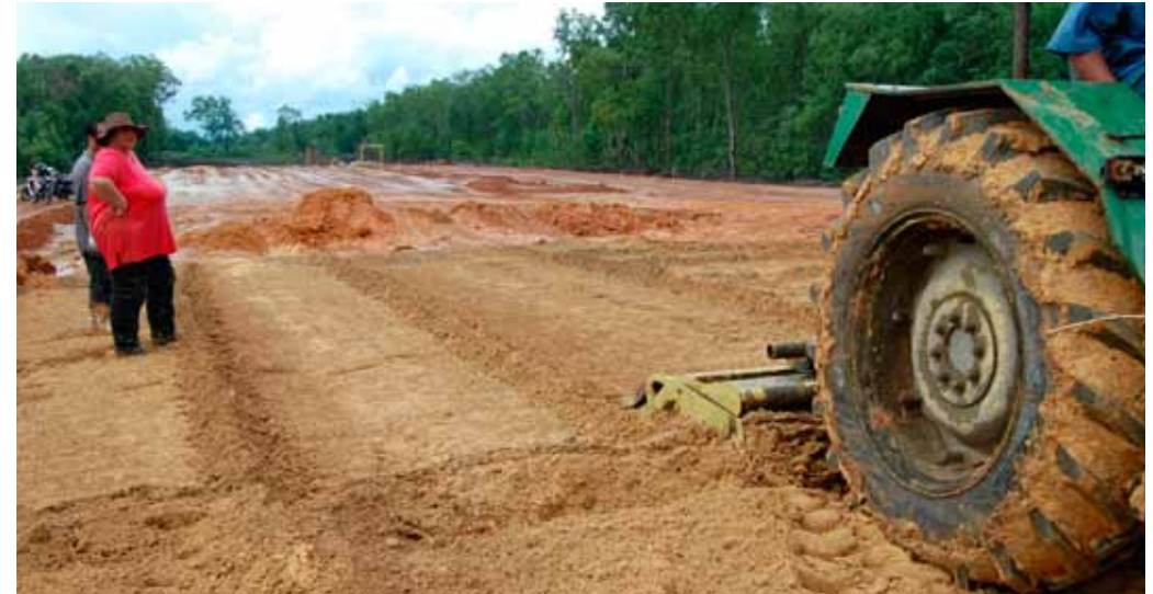
Fräsvorgang des Bindemittel-Bodengemischs für die 2. Lage
